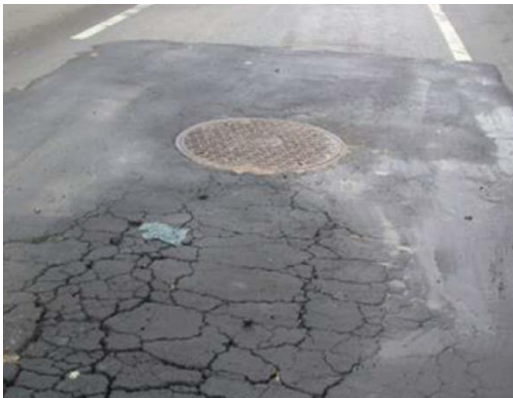
圖4.6.2.5-2（左）地面龜裂（右）回填物質結構性破壞（圖片僅供參考）
