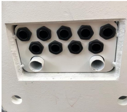
圖4.6.2.6-1 杆體底部開孔示意圖（圖片僅供參考）
