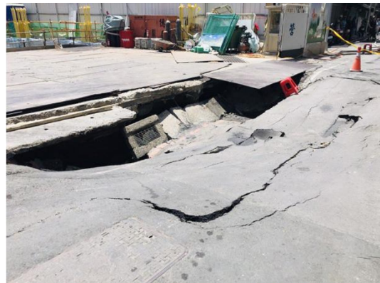
圖4.6.2.5-2（左）地面龜裂（右）回填物質結構性破壞（圖片僅供參考）
