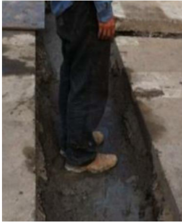
圖4.6.2.5-4 (左) CLSM 回填後請60kg 工作人員站在上面 5分鐘測試 (右) 回填 CLSM 至管溝示意 (圖片僅供參考)
