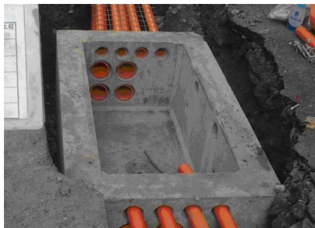
圖4.6.2.7 手孔示意圖（圖片僅供參考）
