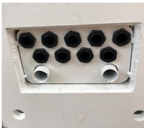
圖4.6.2.6-1 杆體底部開孔示意圖（圖片僅供參考）
