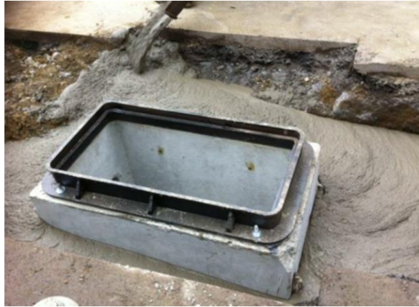
圖4.6.2.5-4 (左) CLSM 回填後請60kg 工作人員站在上面 5分鐘測試 (右) 回填 CLSM 至管溝示意 (圖片僅供參考)
